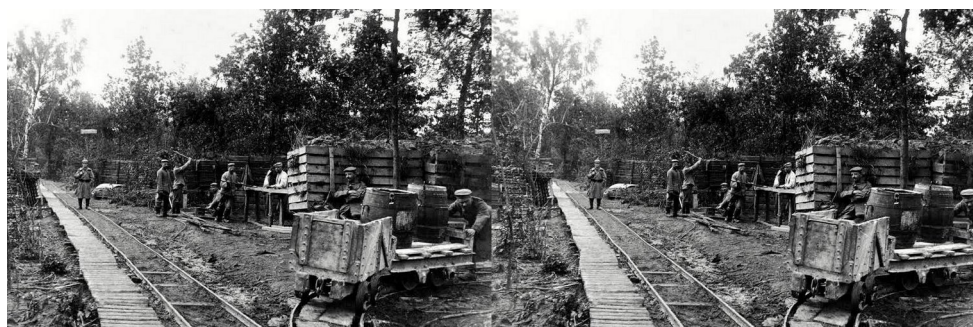
Point de chargement de matériaux divers pour la construction d'abris (bois du Biez - Loriges). Noter les voies de 60 cm et la pousse des wagonnets à la main.
